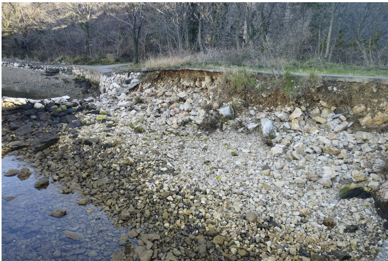
Slika 5. Pogled na istočni dio plaže zahvata: ostaci urušenog potpornog zida i potkopana (armirano)betonska šetnica
