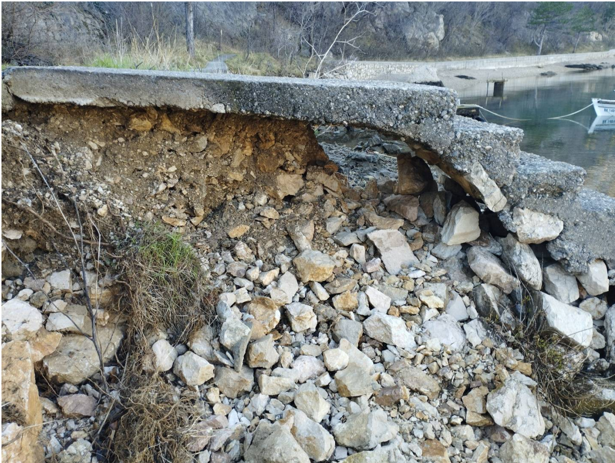
Slika 7. Pogled na potkopane stepenice koje se nalaze pri sredini zahvata
