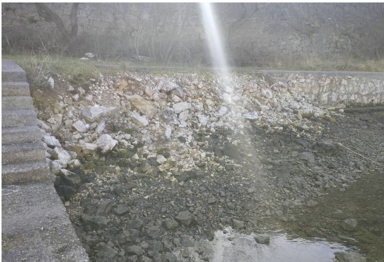
Slika 6. Pogled na zapadni dio plaže zahvata: ostaci urušenog potpornog zida
